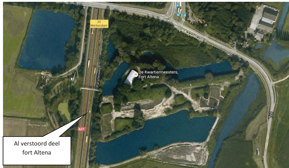
Figuur3.21 Huidige situatie Fort Altena (bron: Google maps)
