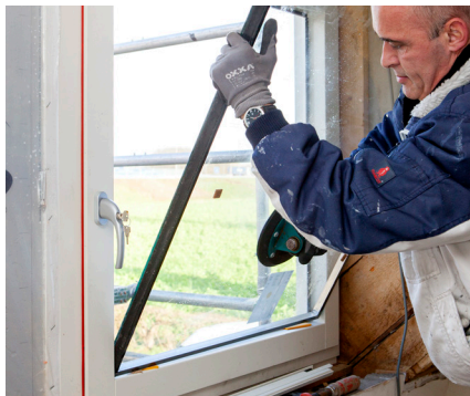
'Geluidisolatie gebeurt bijvoorbeeld door het aanbrengen van dubbel glas, het dichtn van kieren of het aanbrengen van geluiddempende ventilatie.'
